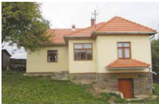
La maison rénovée
